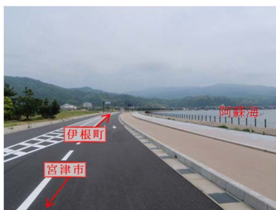
【図35：バイパス整備後】
