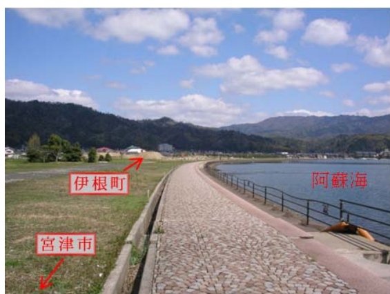
【図34：バイパス整備前】
