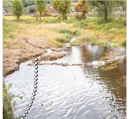
岩屋川のホテル護岸。田中さんが作った中央を横切る水制により、点線部分にあった砂州に流れが当たり、砂州が徐々に消えていった
