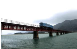
丹鉄由良川橋梁
