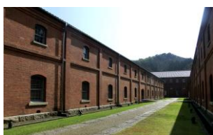
舞鶴旧鎮守府倉庫施設
