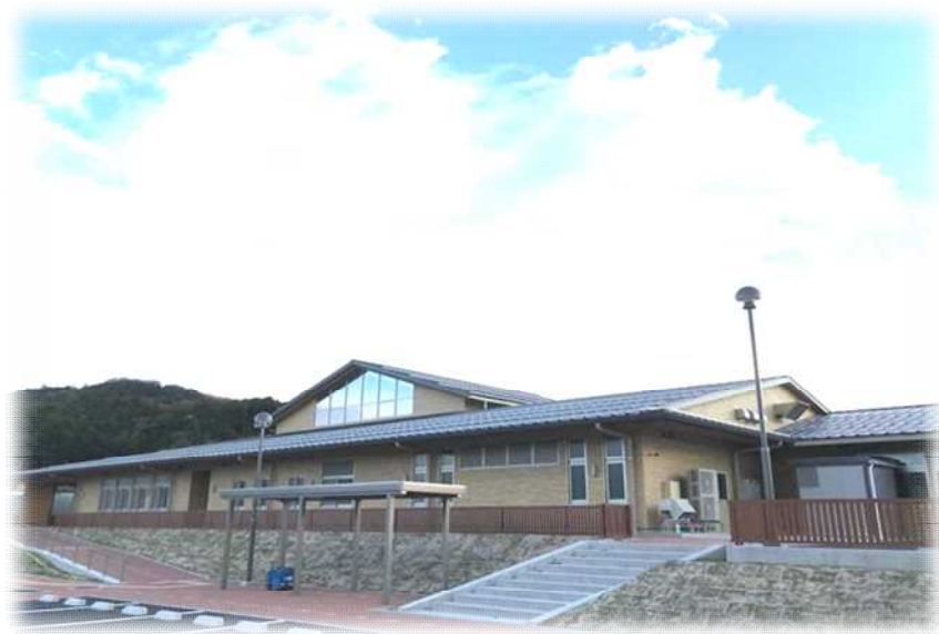
つばきこども園新園舎全景
